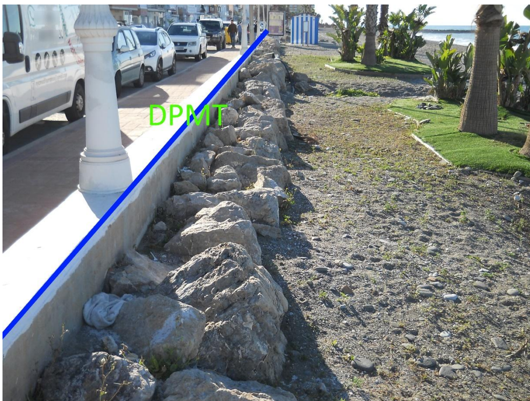
Fotografía 5: Detalle del murete de separación de la playa con el vial y escollera defensiva.
