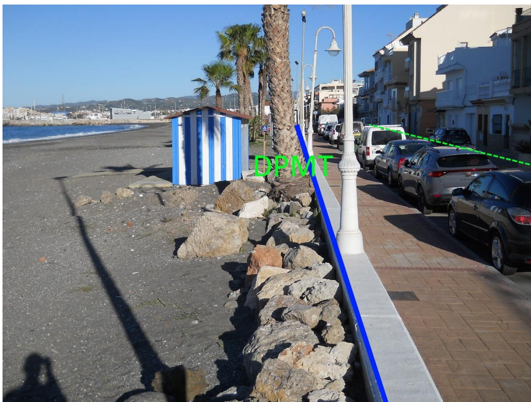
Fotografía 8: Murete de separación del vial con la playa y escollera defensiva en las proximidades del vértice M-2. Ocupaciones (vestuarios).
