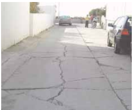
Estado del pavimento antes de la actuación.
